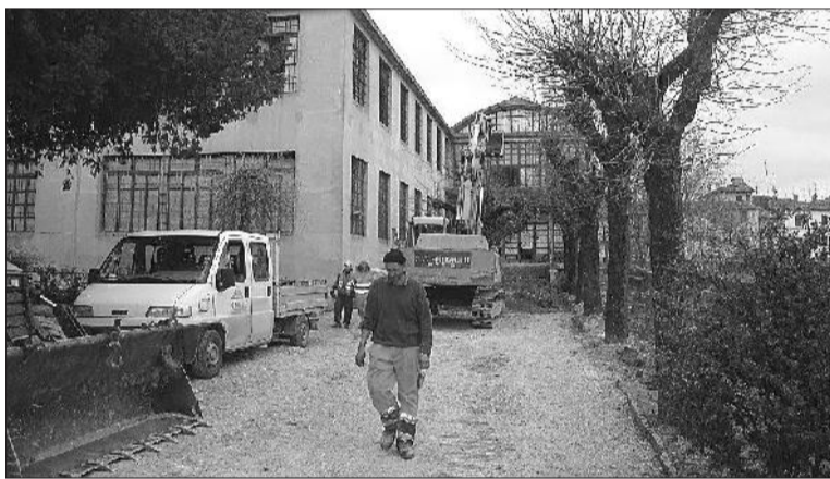
Ex Fat In azione le macchine operatrici per la demolizione
